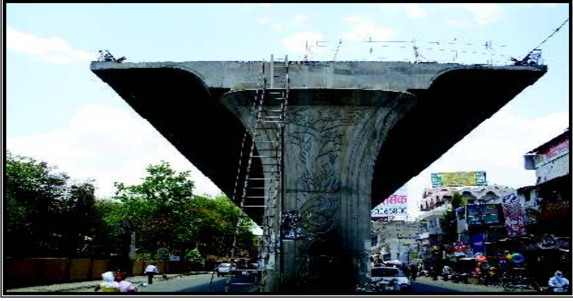
छायाचित्र ७ग: २००७-०८ मध्ये आइआरडीपीच्या अंतर्गत जयस्तंभ चौकाजवळ उड्डानपुलाचे बांधकाम
